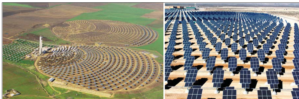
а) б) Рис. 3. Солнечные электростанции (по источникам [2; 3]): а – башенного типа; б – панельного (модульного) типа
